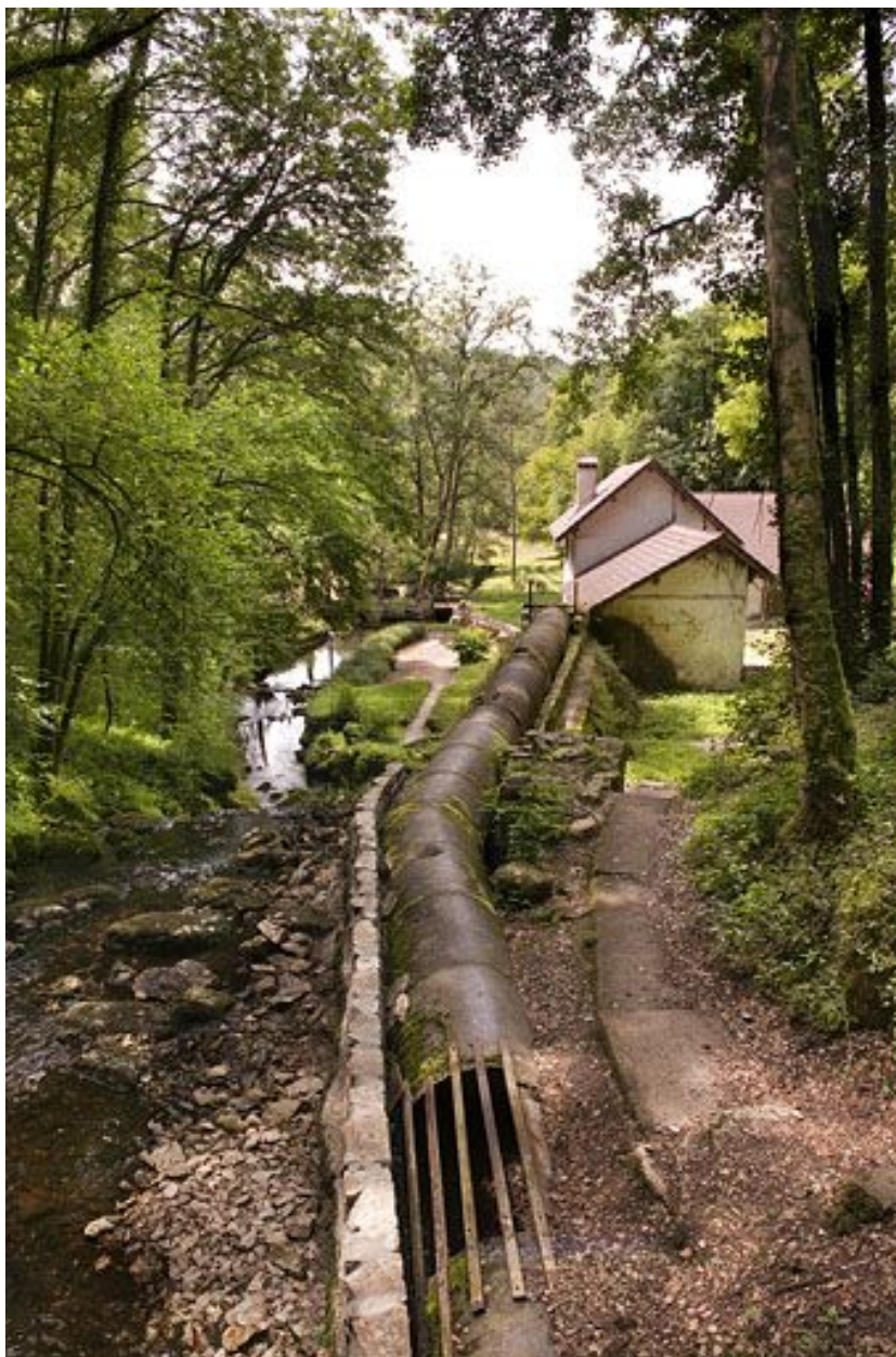
La conduite d'amenée.
