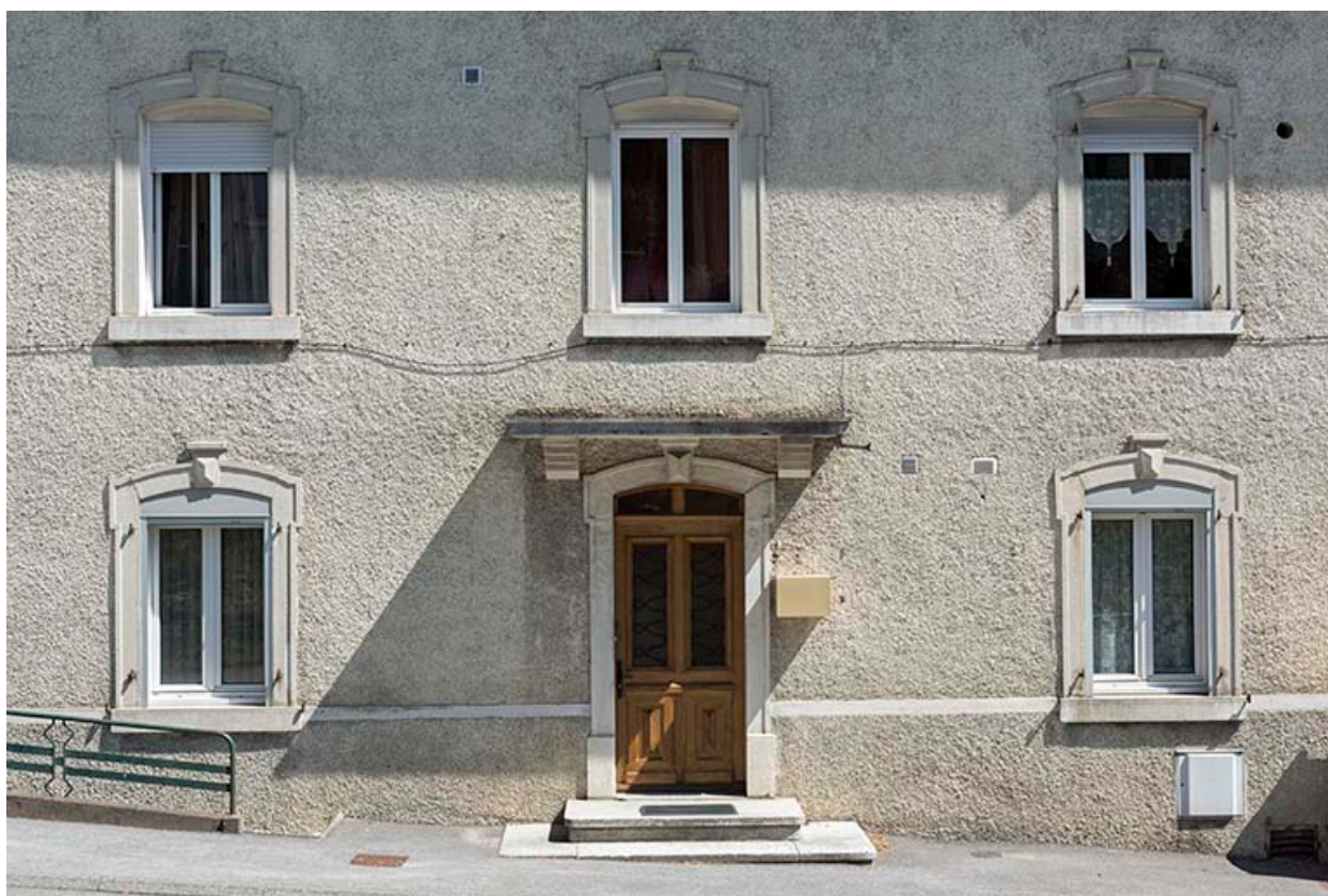
Façade antérieure : baies du bâtiment d'origine.
