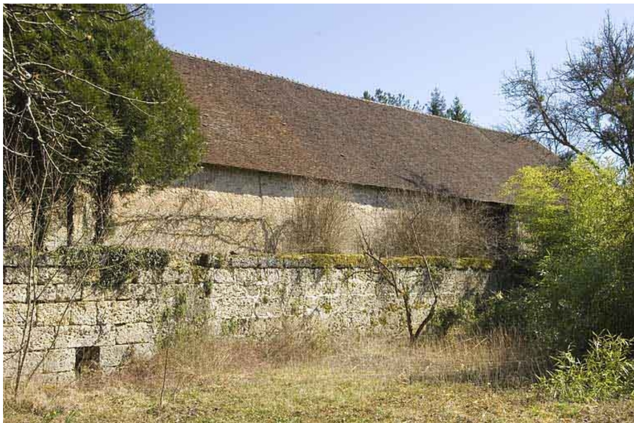
Façade ouest de la halle à charbon.
