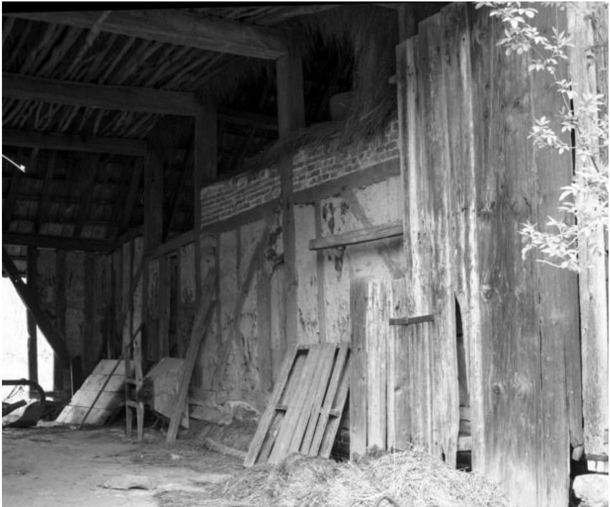
Aire de battage, mur droit.
