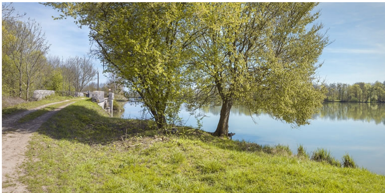
Vue d'ensemble, d'aval.
