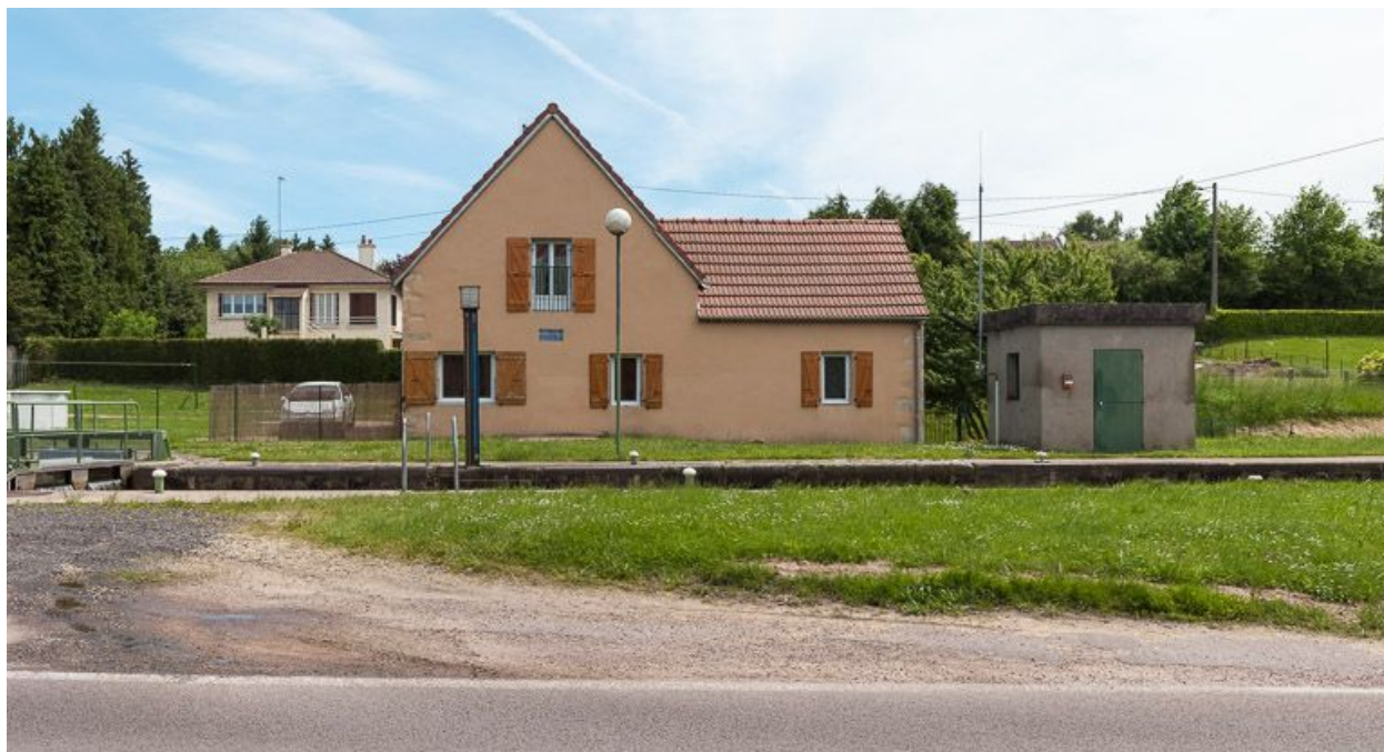
La maison éclusière vue de face.
