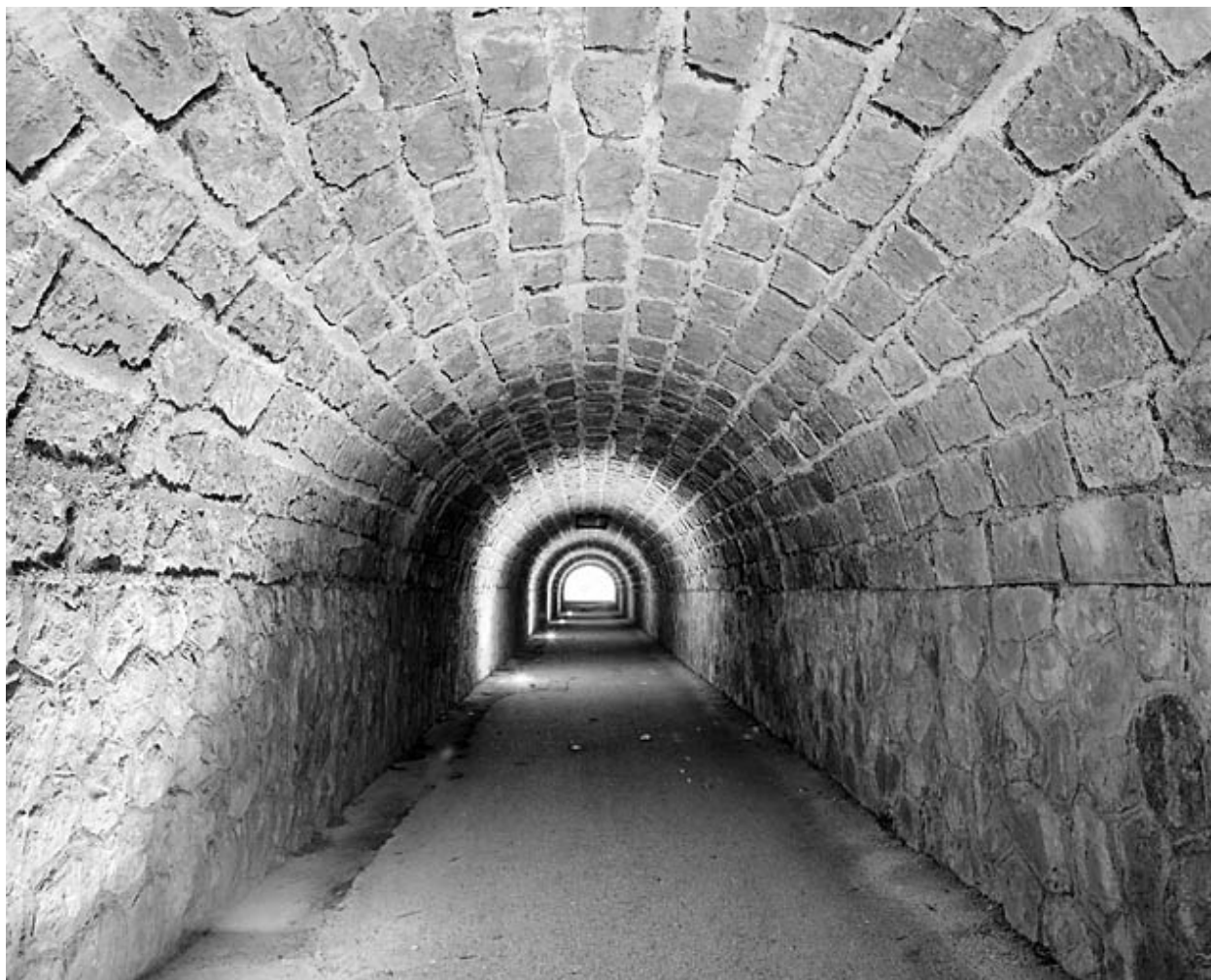
Passage souterrain (sous les voies) : intérieur.
