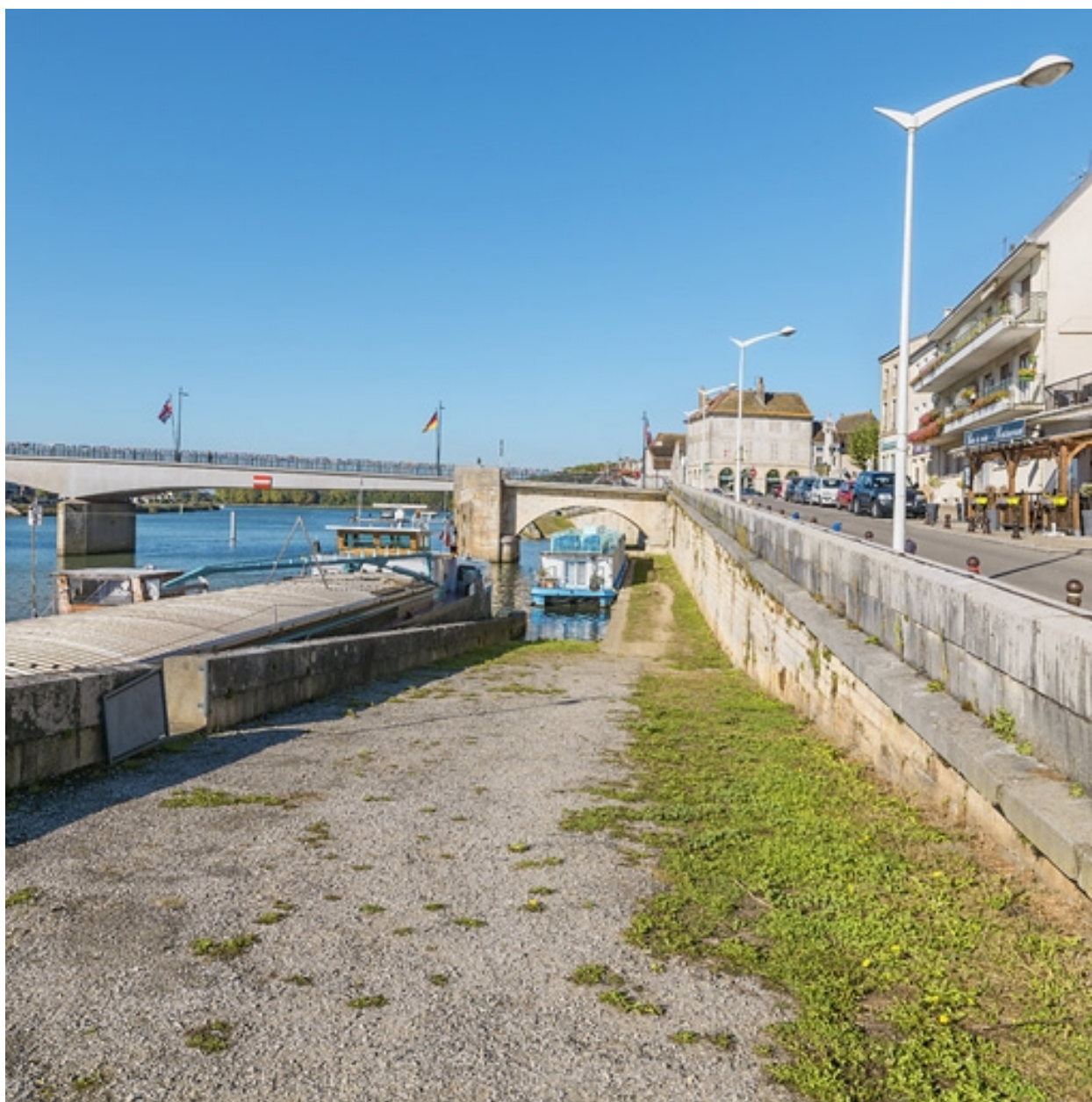
Arche maçonnée du pont, rive droite.
