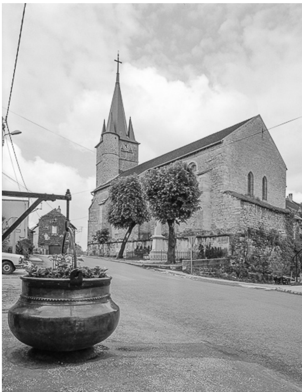
Extérieur : façade latérale droite et chevet.
