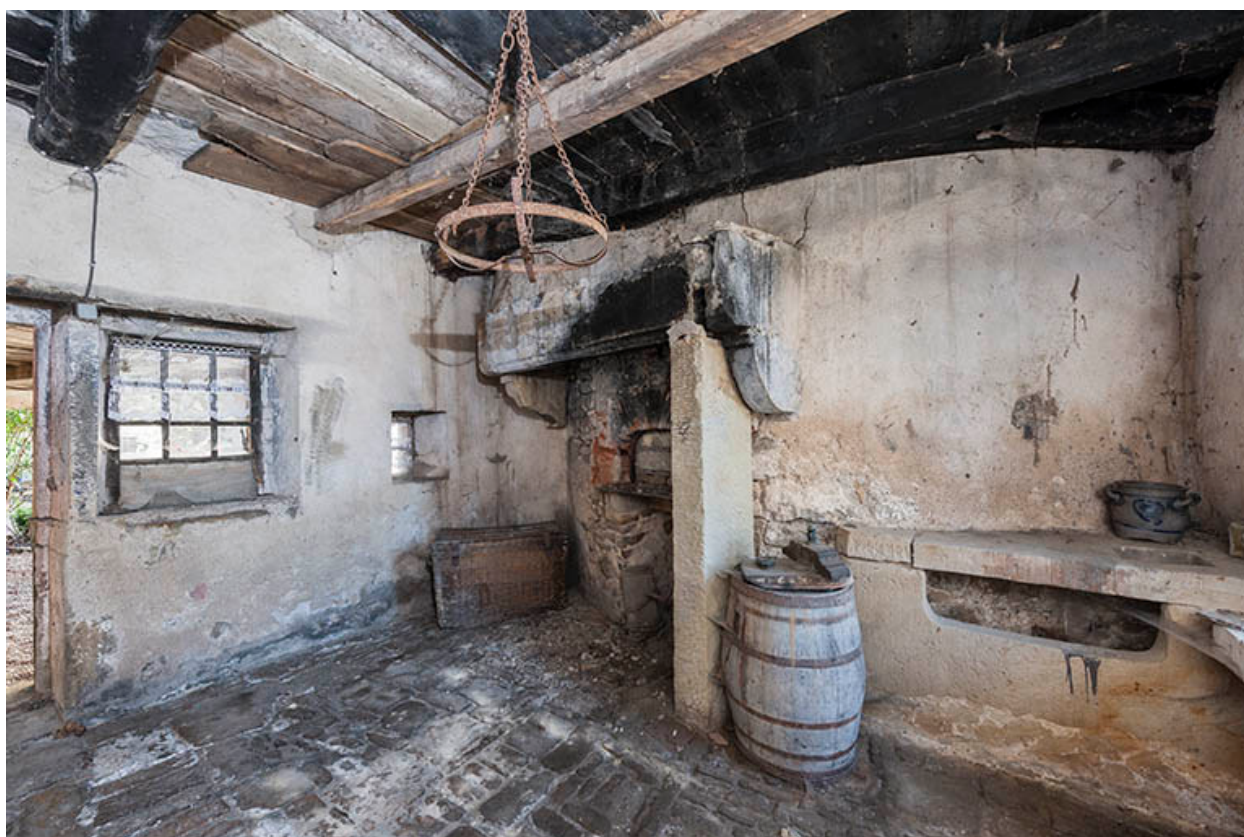
Rez-de-chaussée du pigeonnier circulaire.
