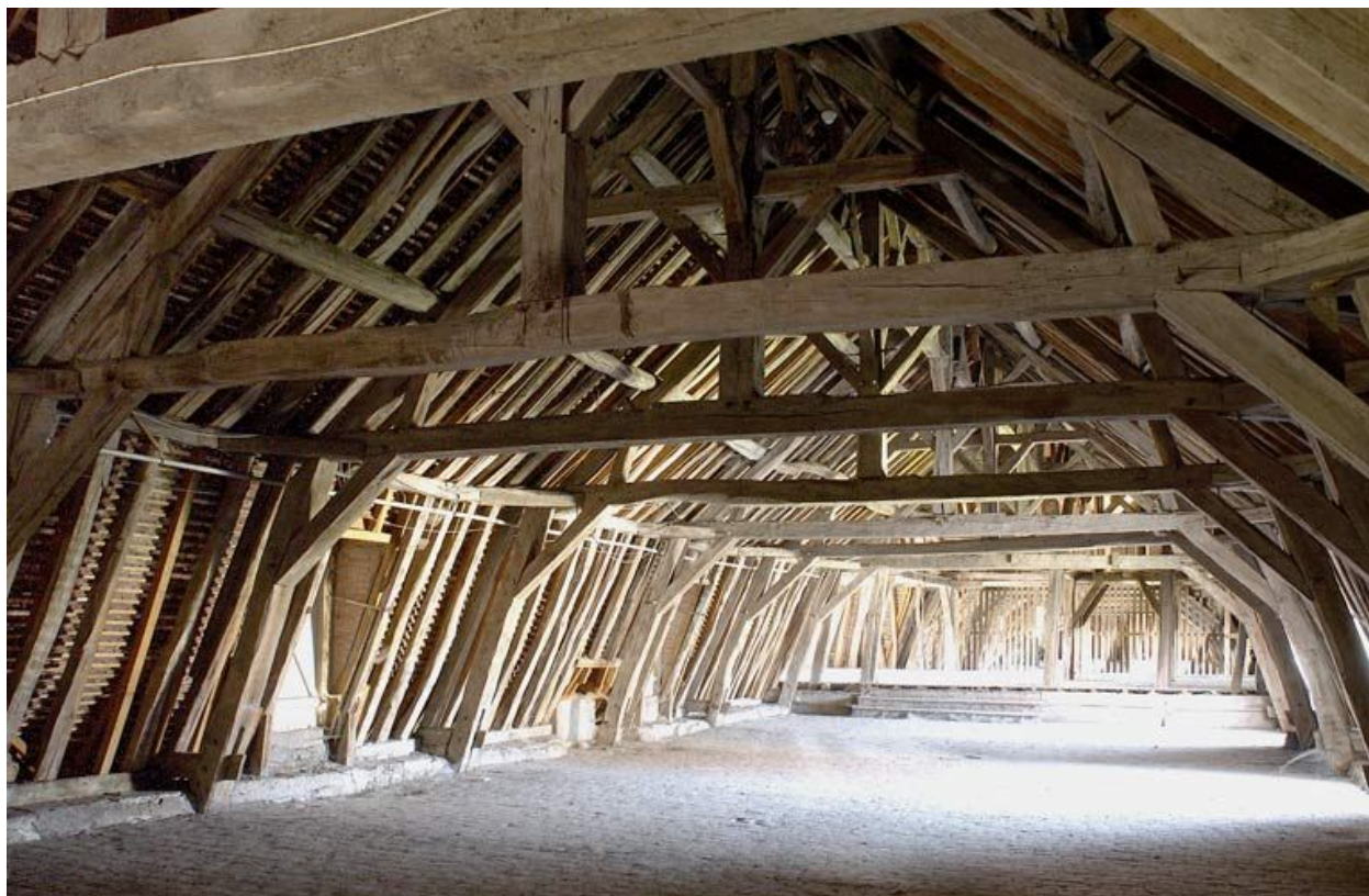
Aile droite : charpente.
