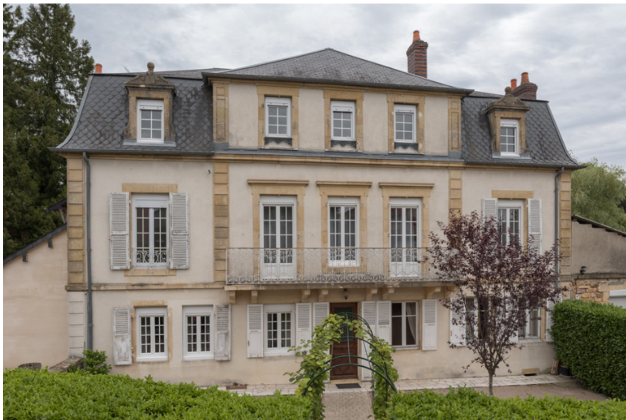
Façade côté rue.
