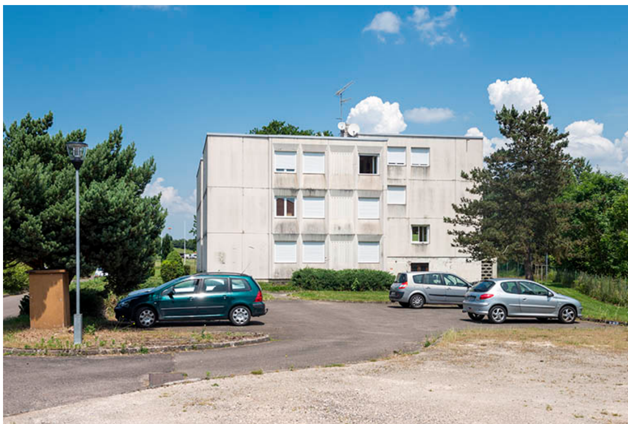
Façade sud des logements.
