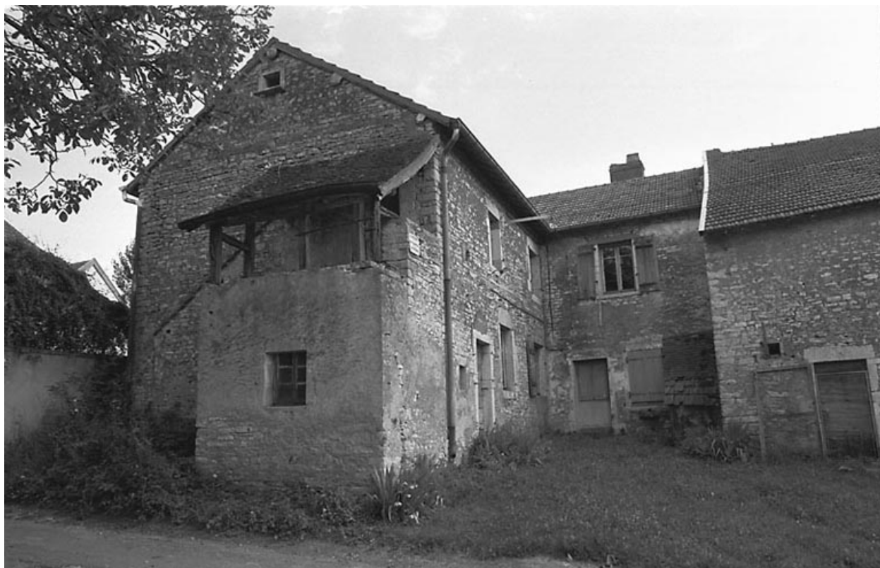
Partie gauche : habitation avec escalier extérieur.
