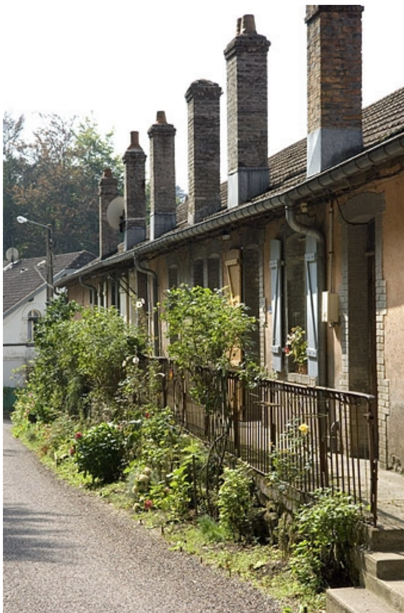
Façade des logements ouvriers route de Plombières.
