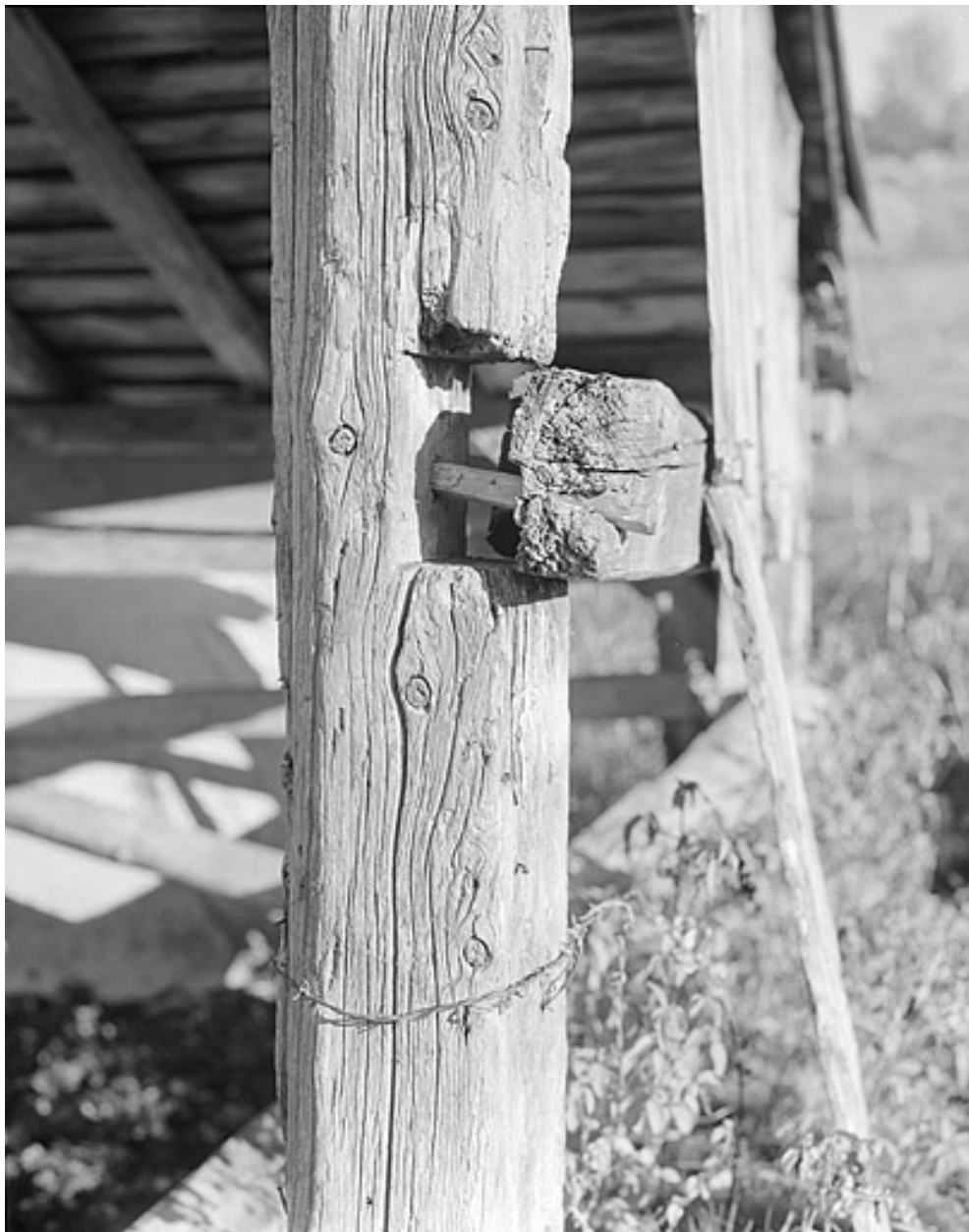
Assemblage à mi-bois poteaux-panne par une cheville.
