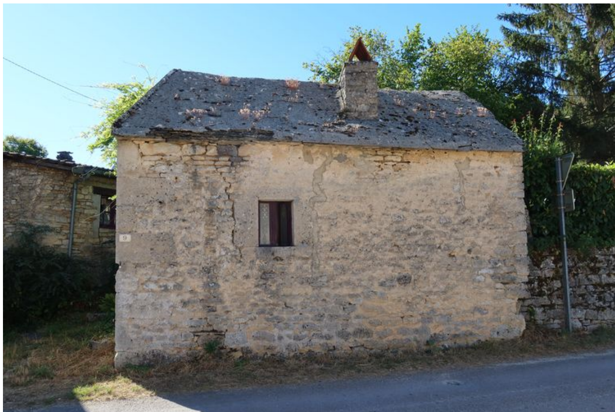
Vue de la façade depuis le nord-est.
