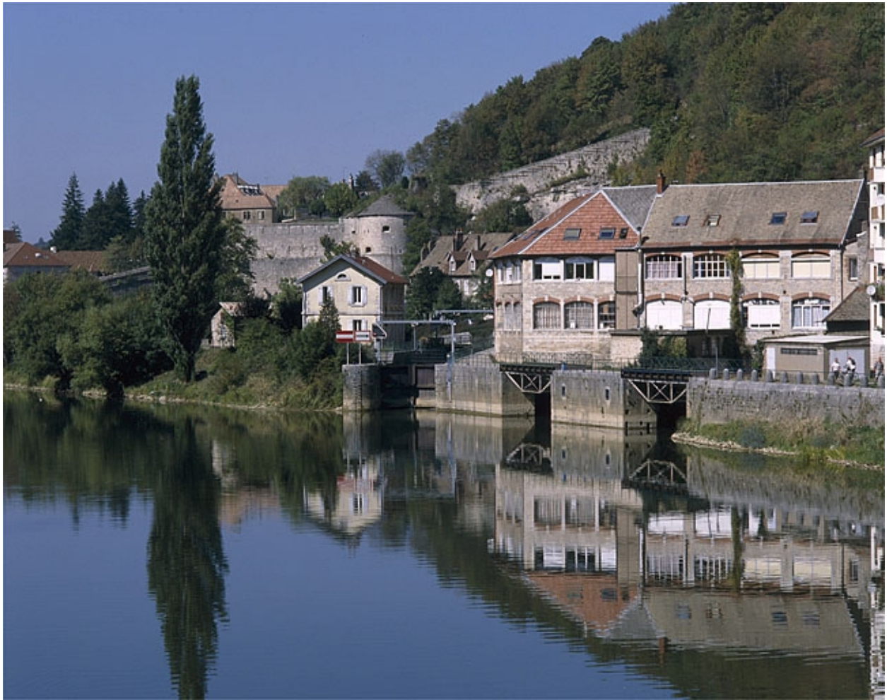
Besançon : maison d'éclusier n° 51 de Tarragnoz.
