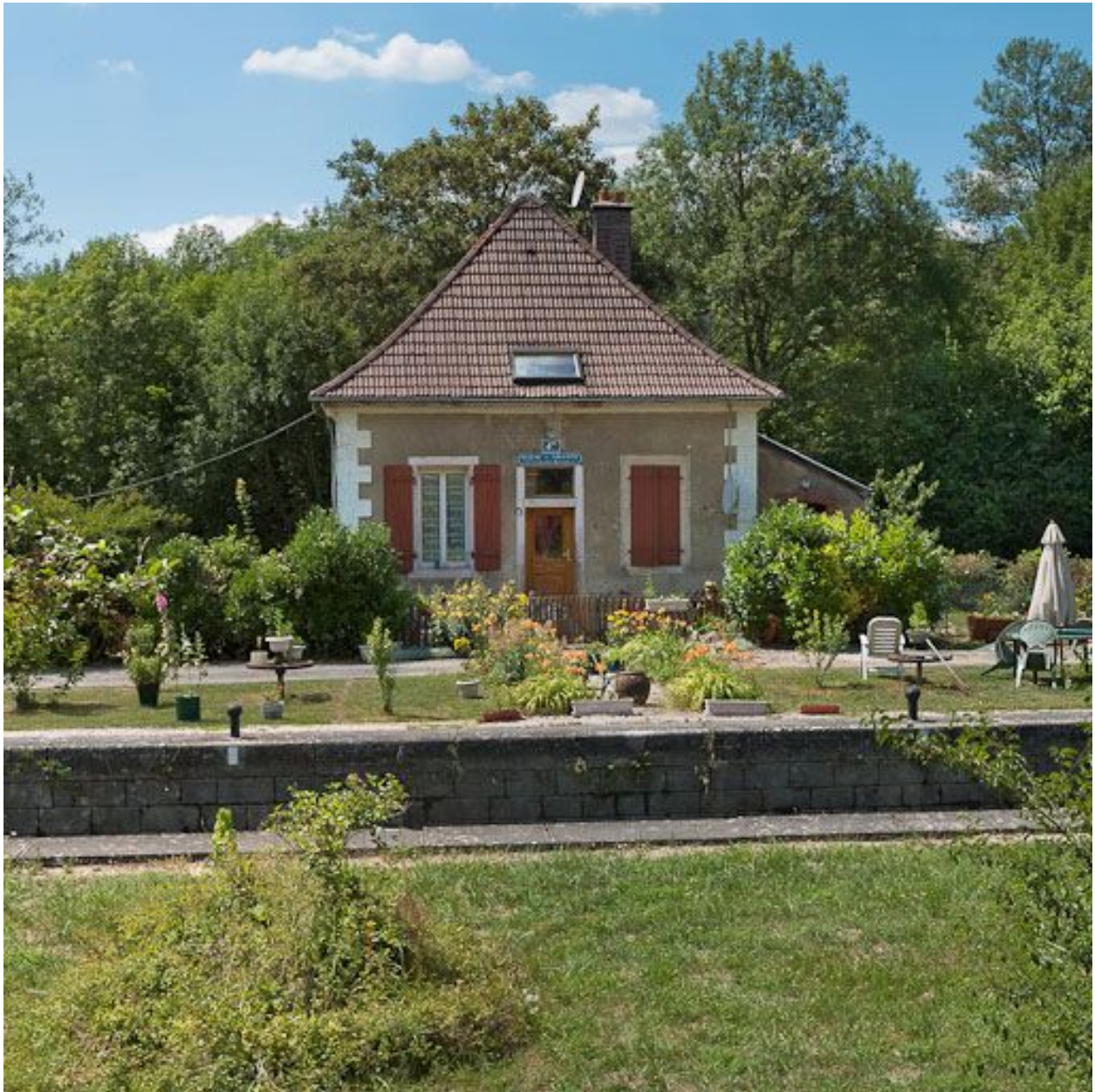
Vue de face de la maison éclusière.
