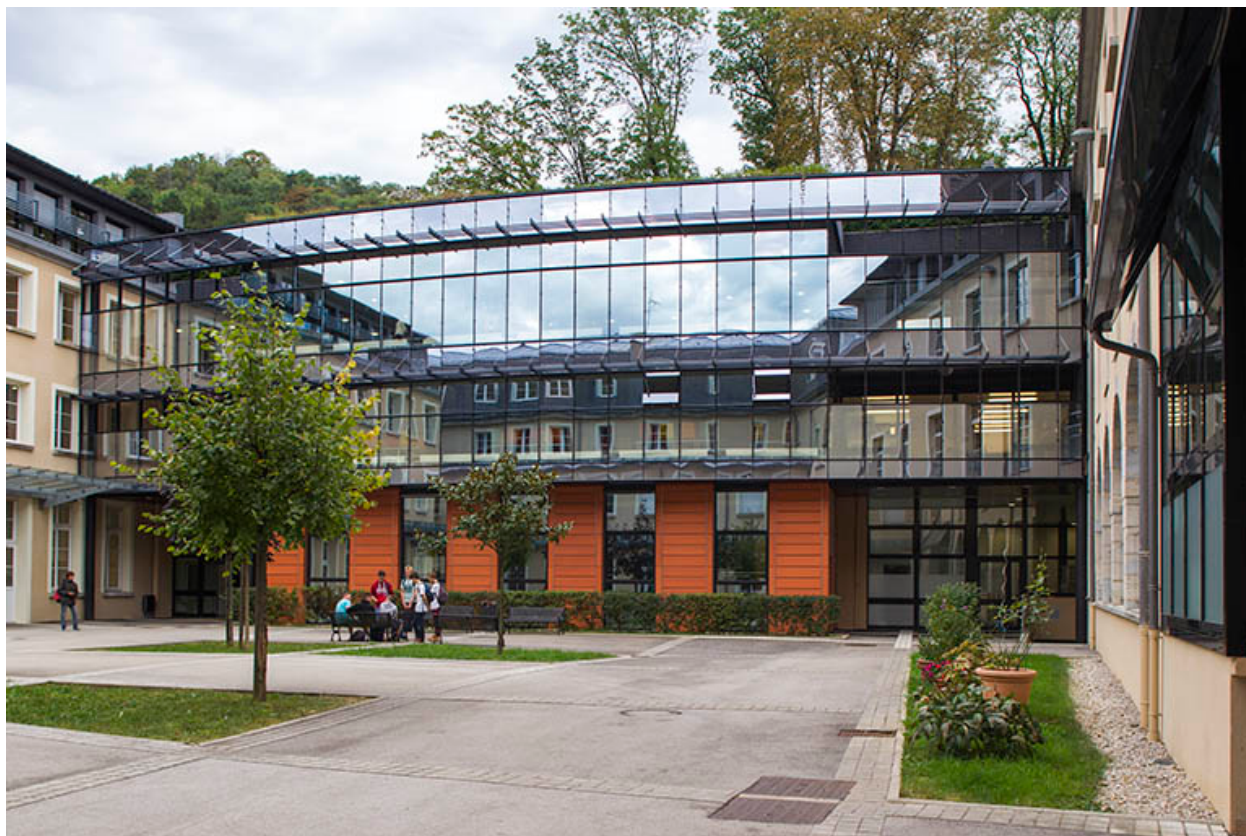
Aile Est : façade antérieure sur cour.
