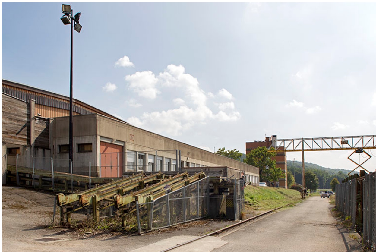
Atelier : façade ouest.
