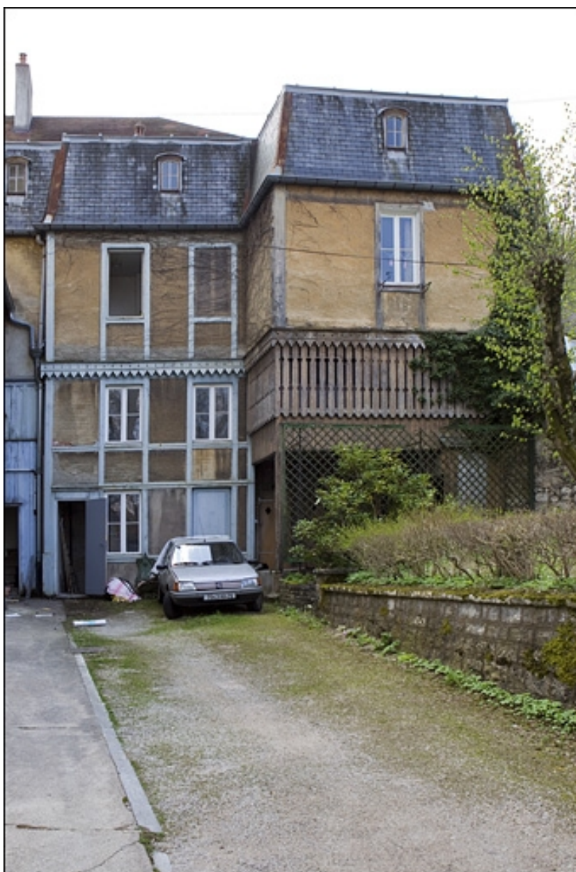
Détail de l'aile sur cour, de face.
