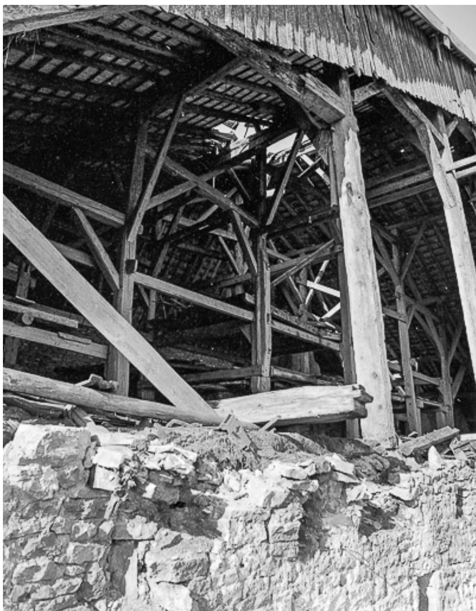
Ferme : facade postérieure (?) : détail.
