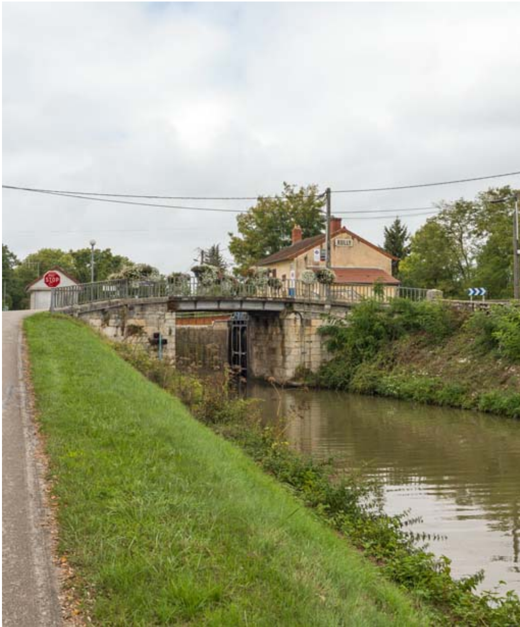
Vue d'ensemble du pont.
