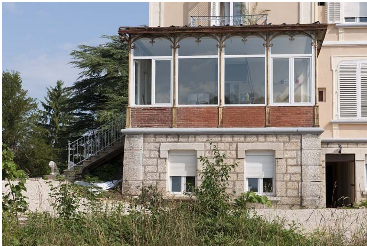
Détail de la véranda.
