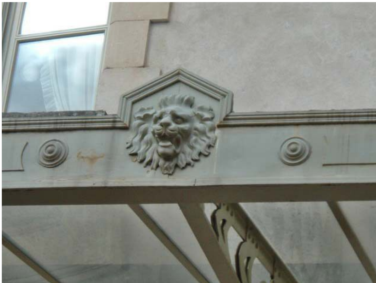
Vue de détail du mascaron (tête de lion) de la galerie extérieure à structure métallique (fonte).
