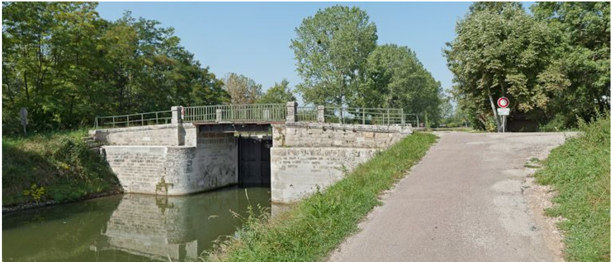
Vue du pont sur écluse depuis l'aval.
