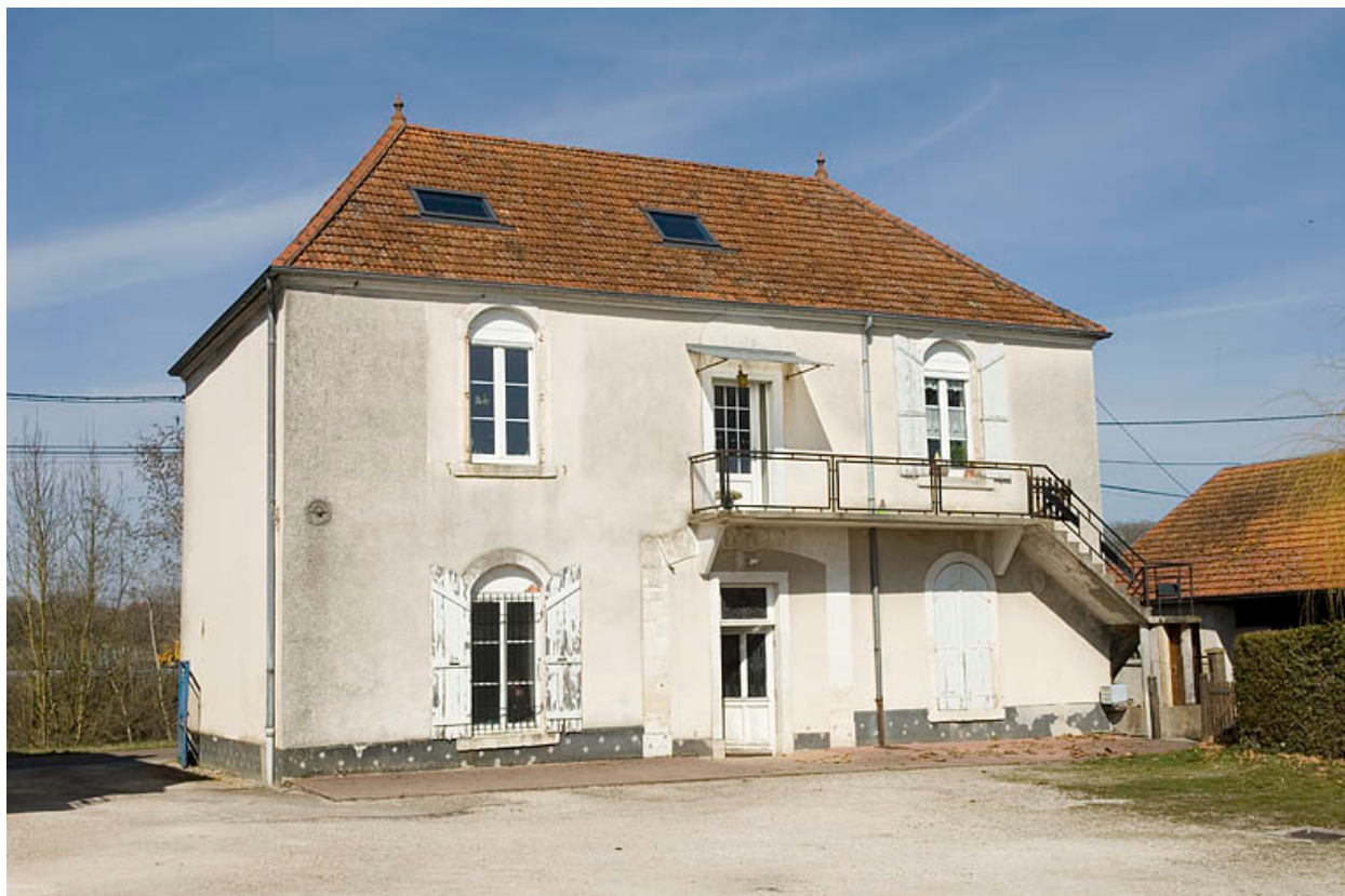
Logement patronal et bureau. Façade sud.
