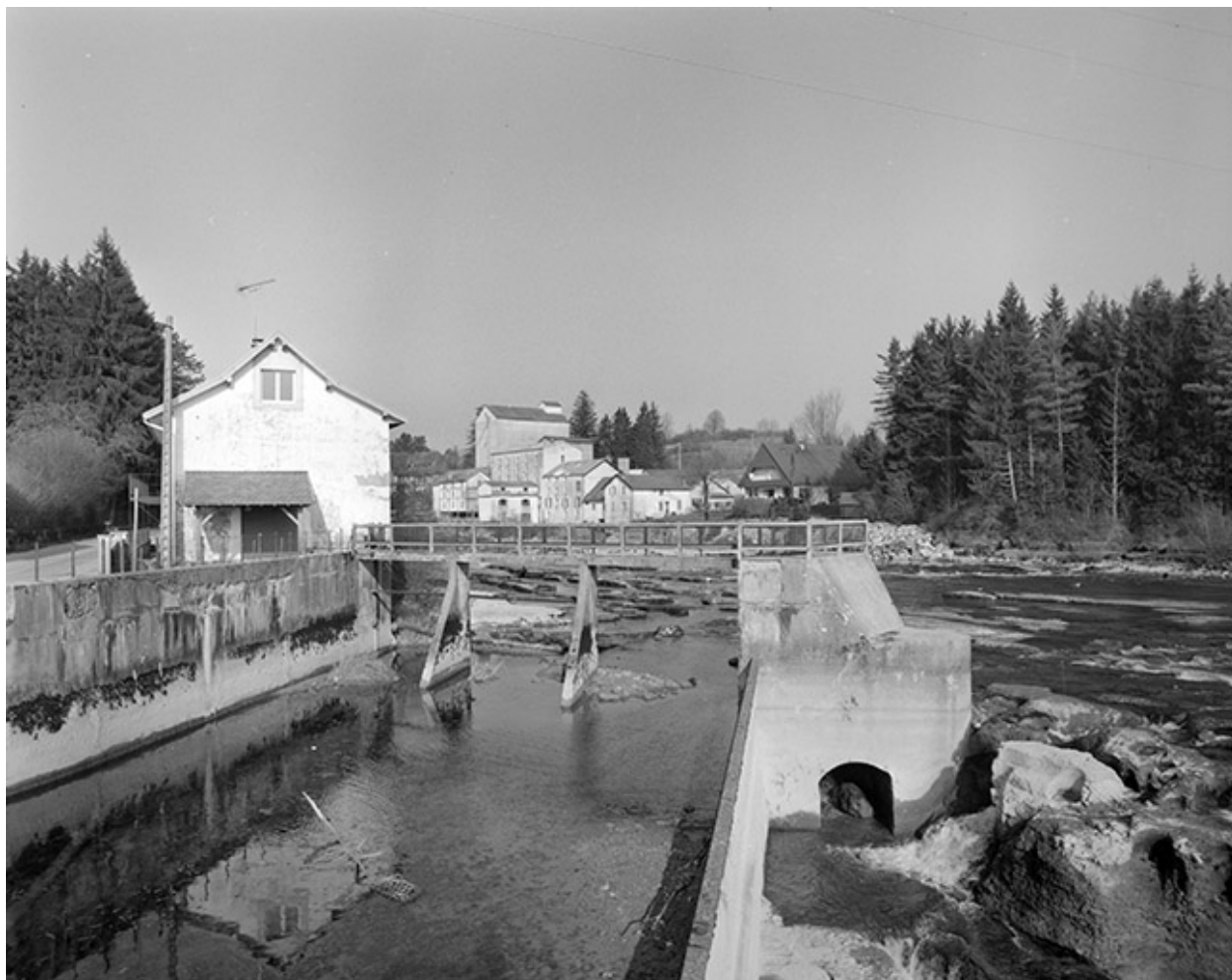
Logement et canal d'amenée.
