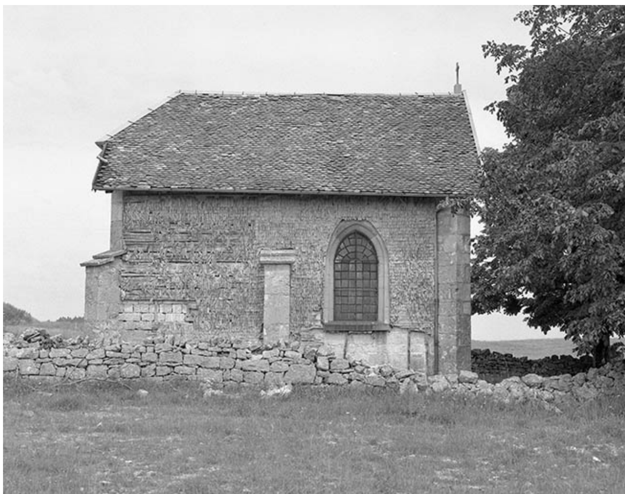
Façade latérale nord.
