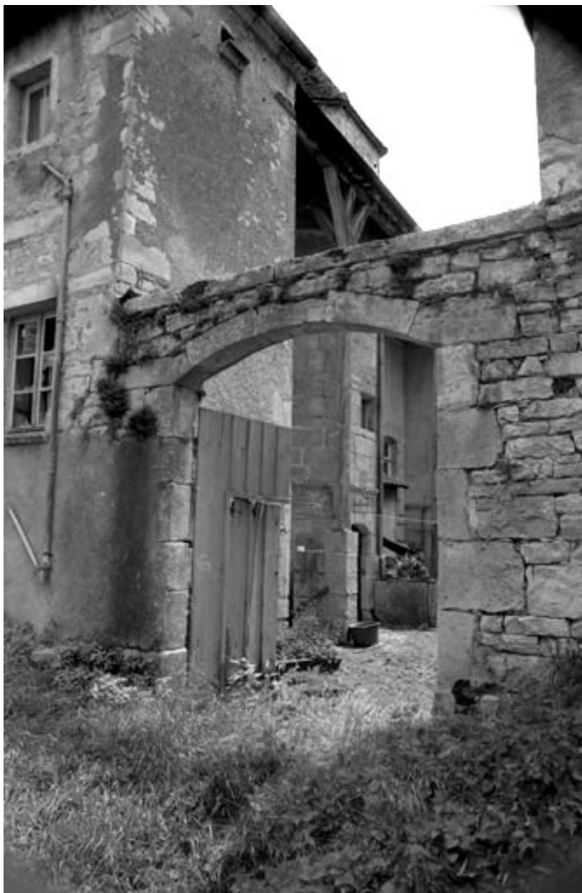
Cour sur façade postérieure.
