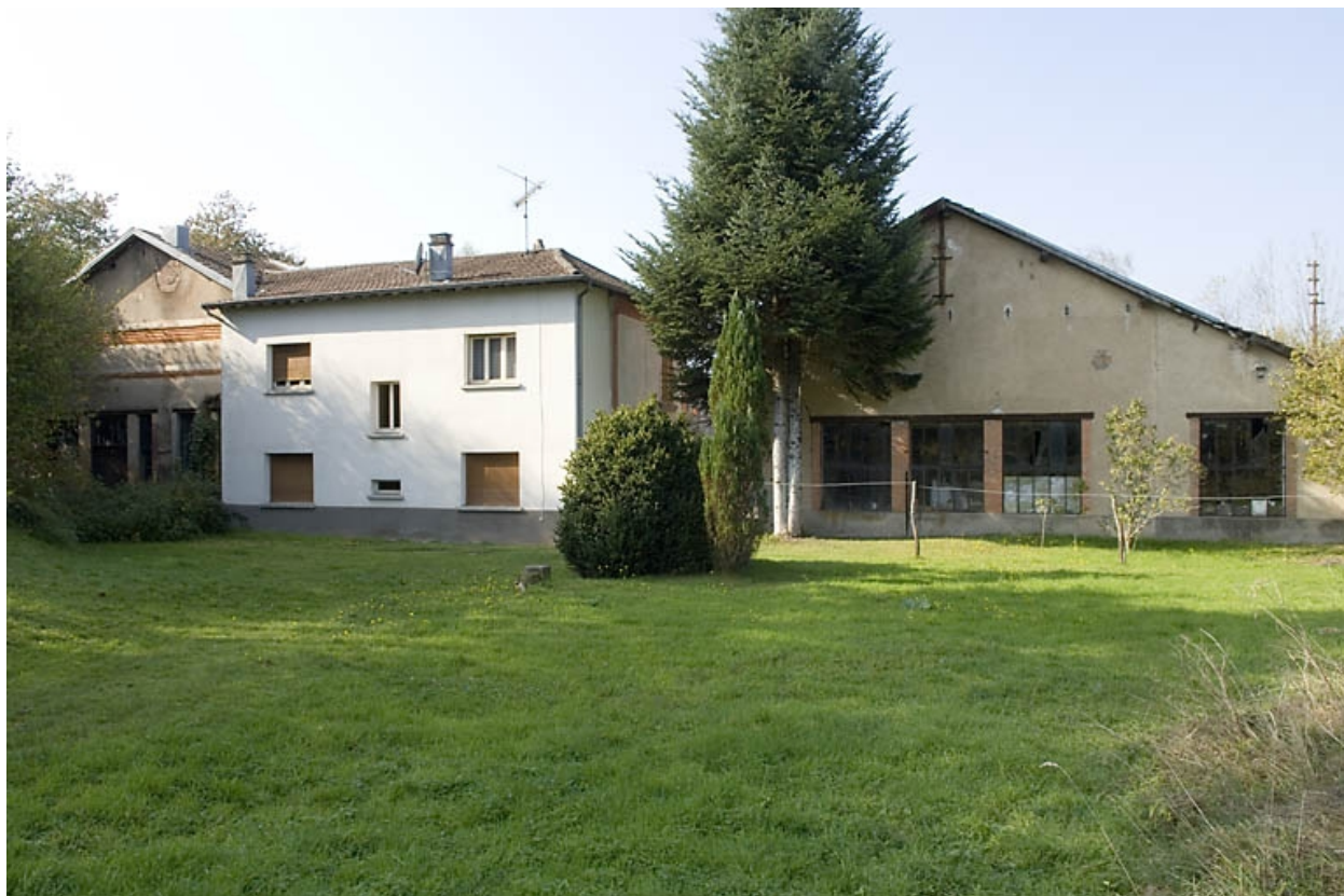
Façades postérieures depuis l'est.
