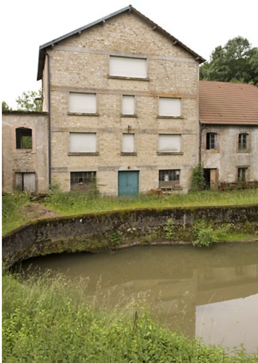
Façade de l'atelier de fabrication.
