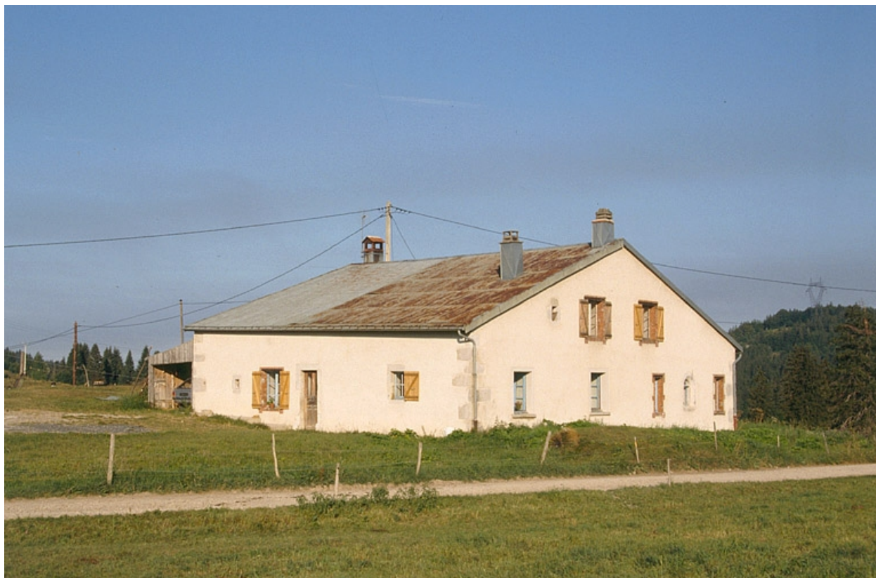
Façade antérieure et face droite.
