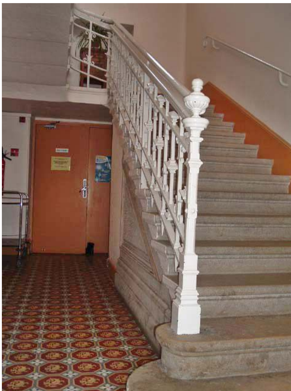
Vue intérieure, escalier en fonte au départ du rez-de-chaussée et carrelage en ciment.
