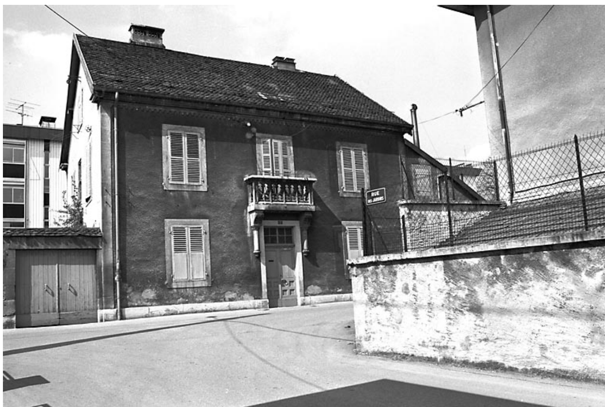
Maison située 7 rue des Remparts.
