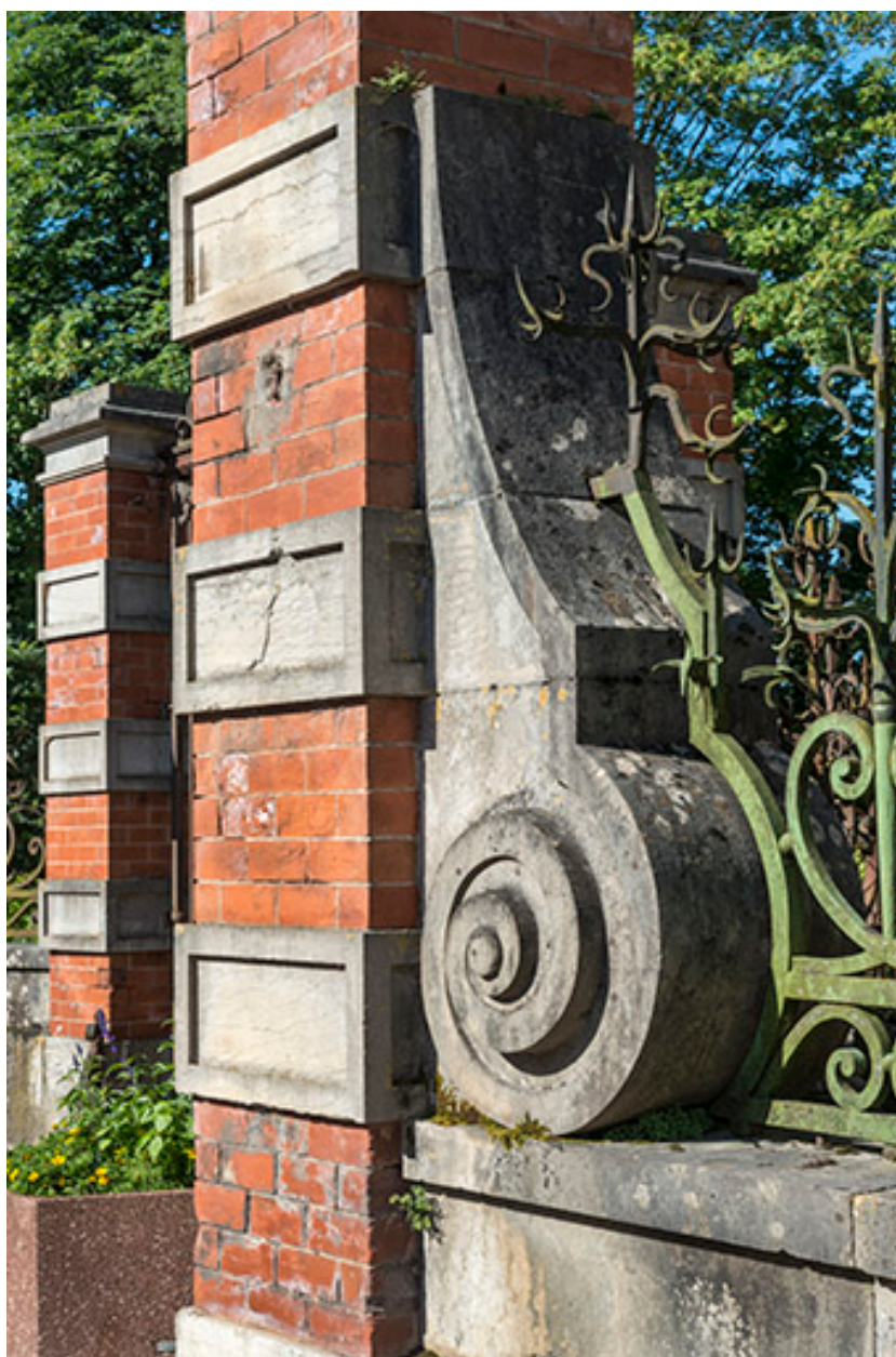
Clôture (grille) sur la rue Armand Paulmard.
