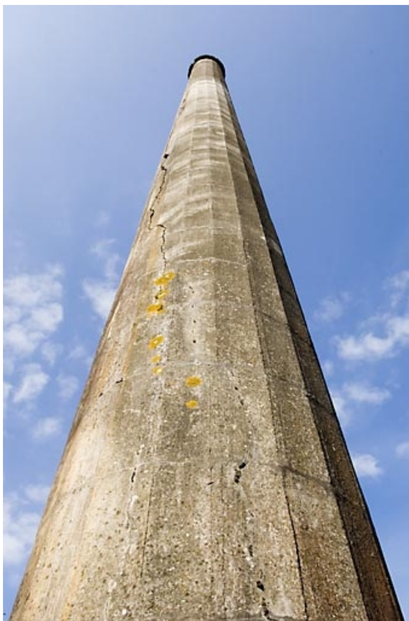
Cheminée vue en contre-plongée (1).
