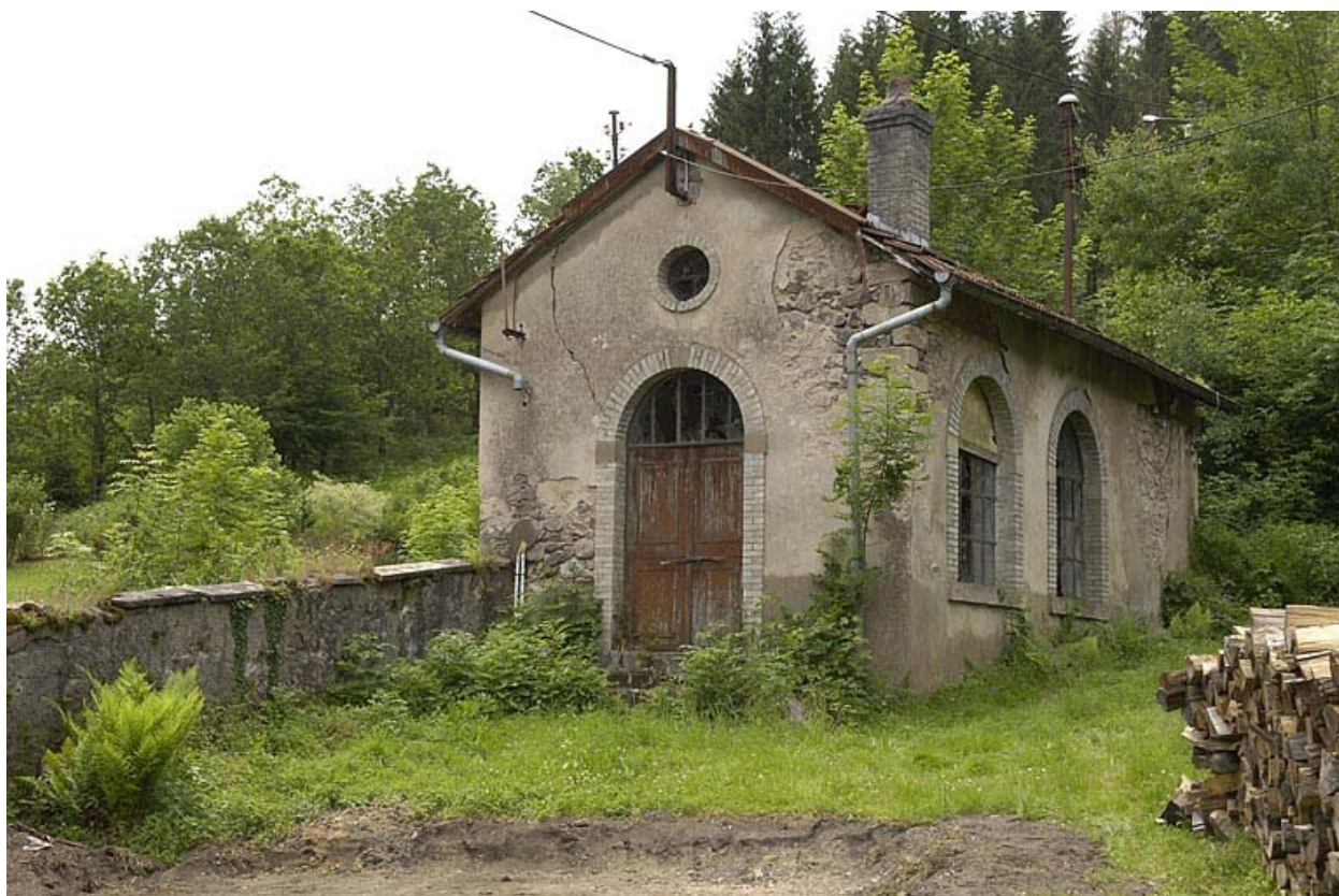
Ancienne centrale hydroélectrique.
