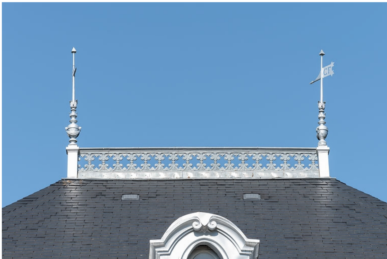
Crête et épis de faîtage.
