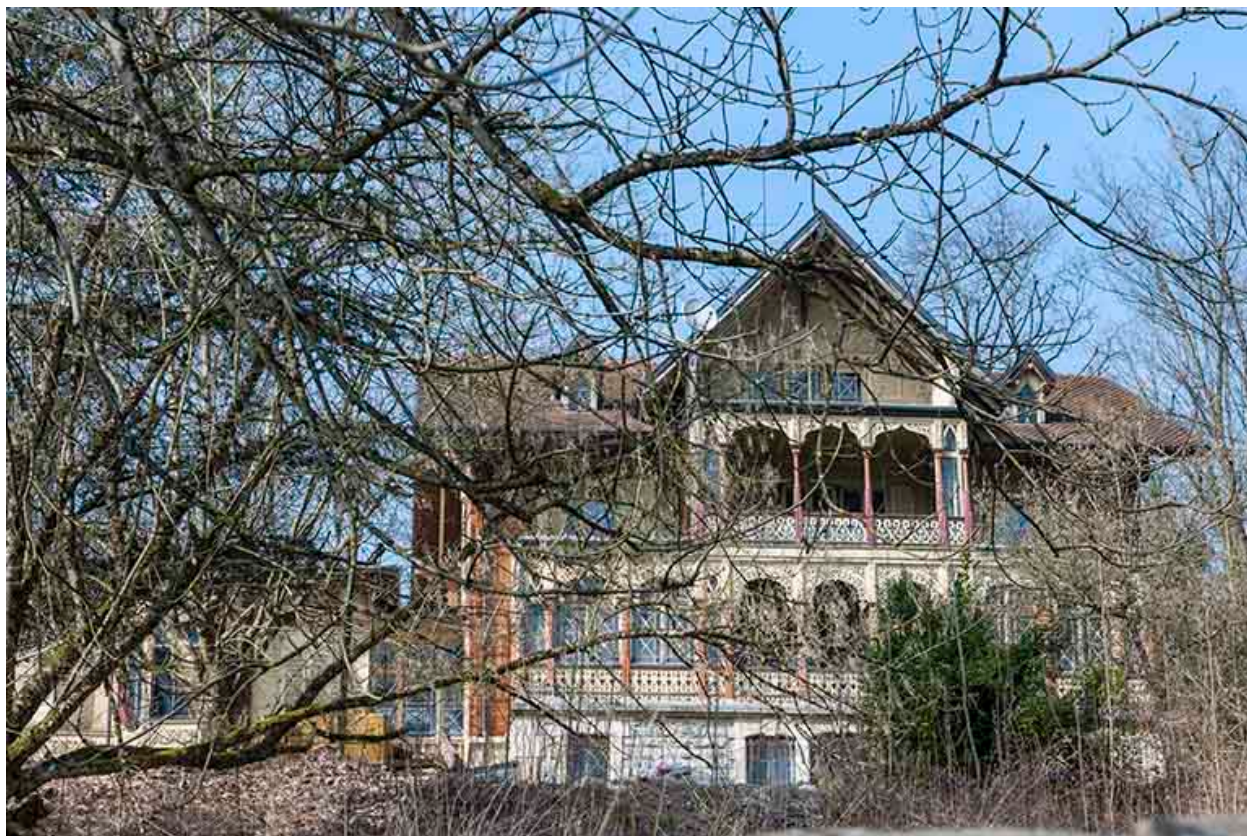
Façade sud du logement patronal.
