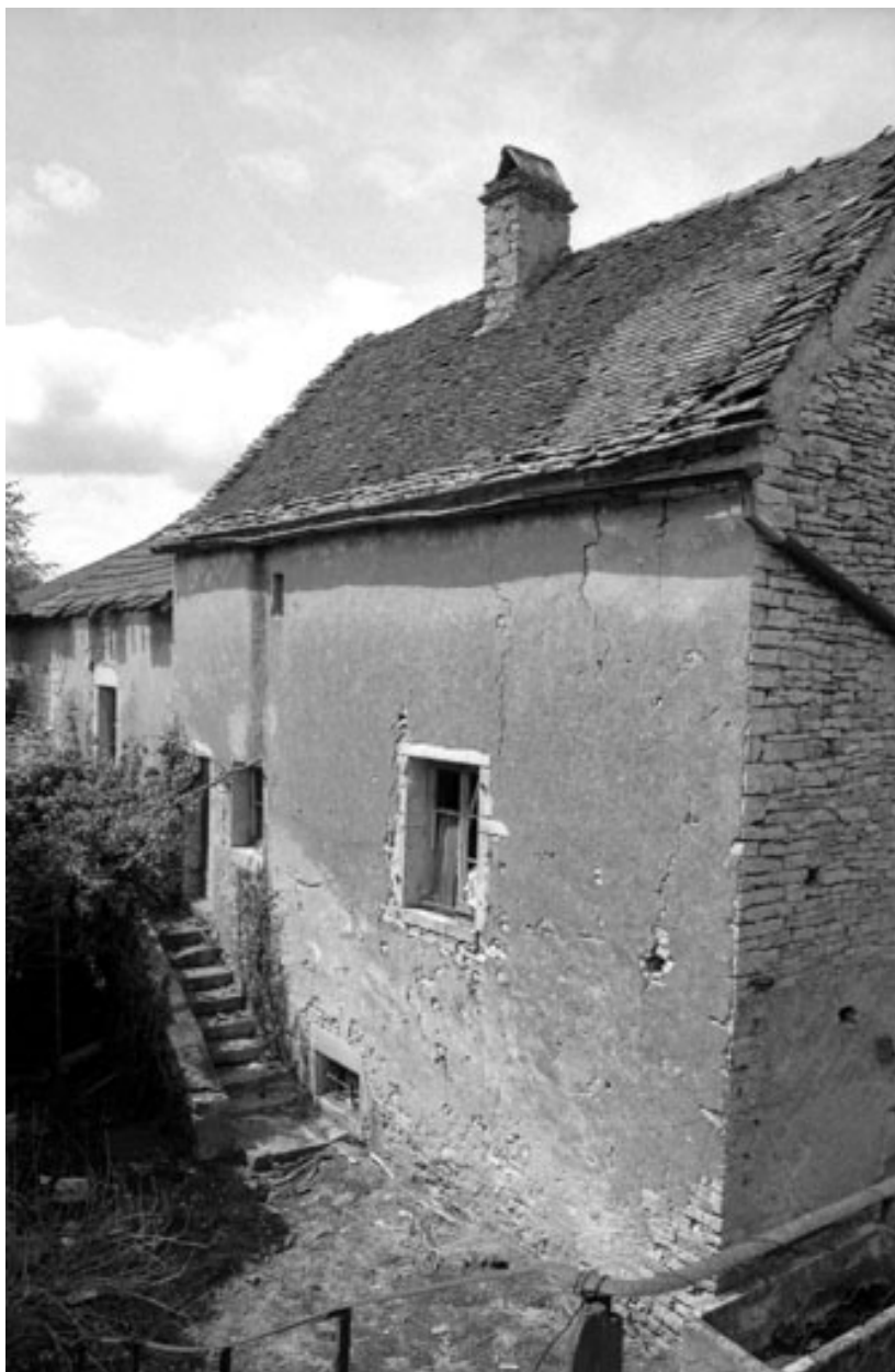
Habitation sur cave dans la cour, avec escalier extérieur.
