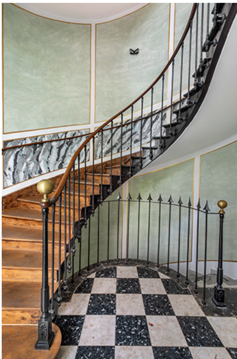
Départ de l'escalier principal (aile sud).
