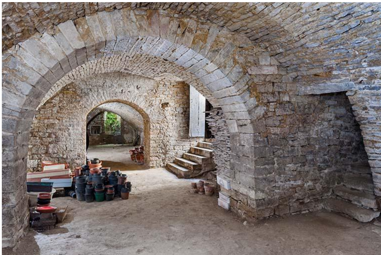
Vue générale de la cave
