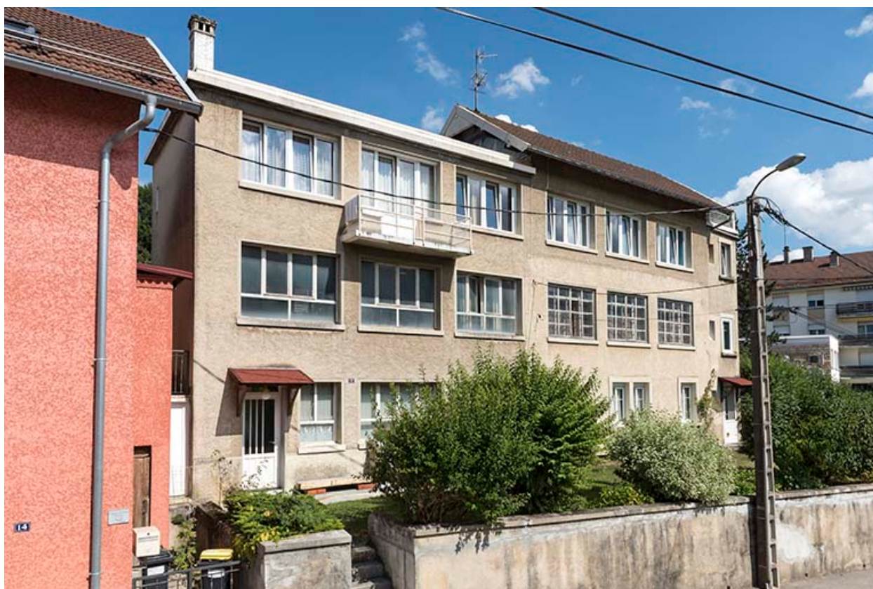
Façade sud, de trois quarts gauche.
