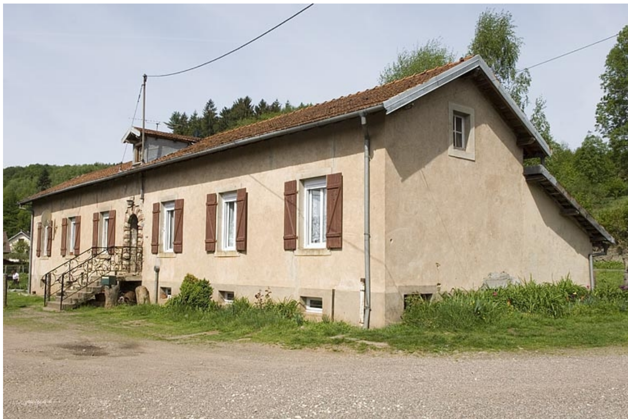
Logement ouvrier (ouest).
