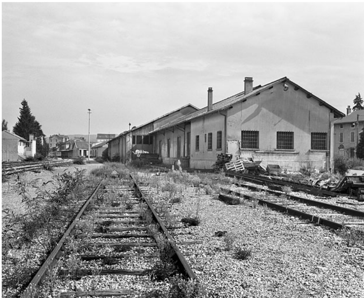
Entrepôts, depuis le sud-ouest (côté La Cluse).
