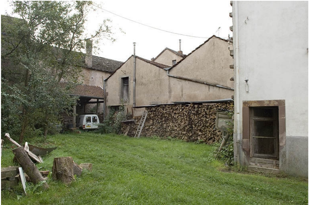
Cour située devant l'atelier de distillation.
