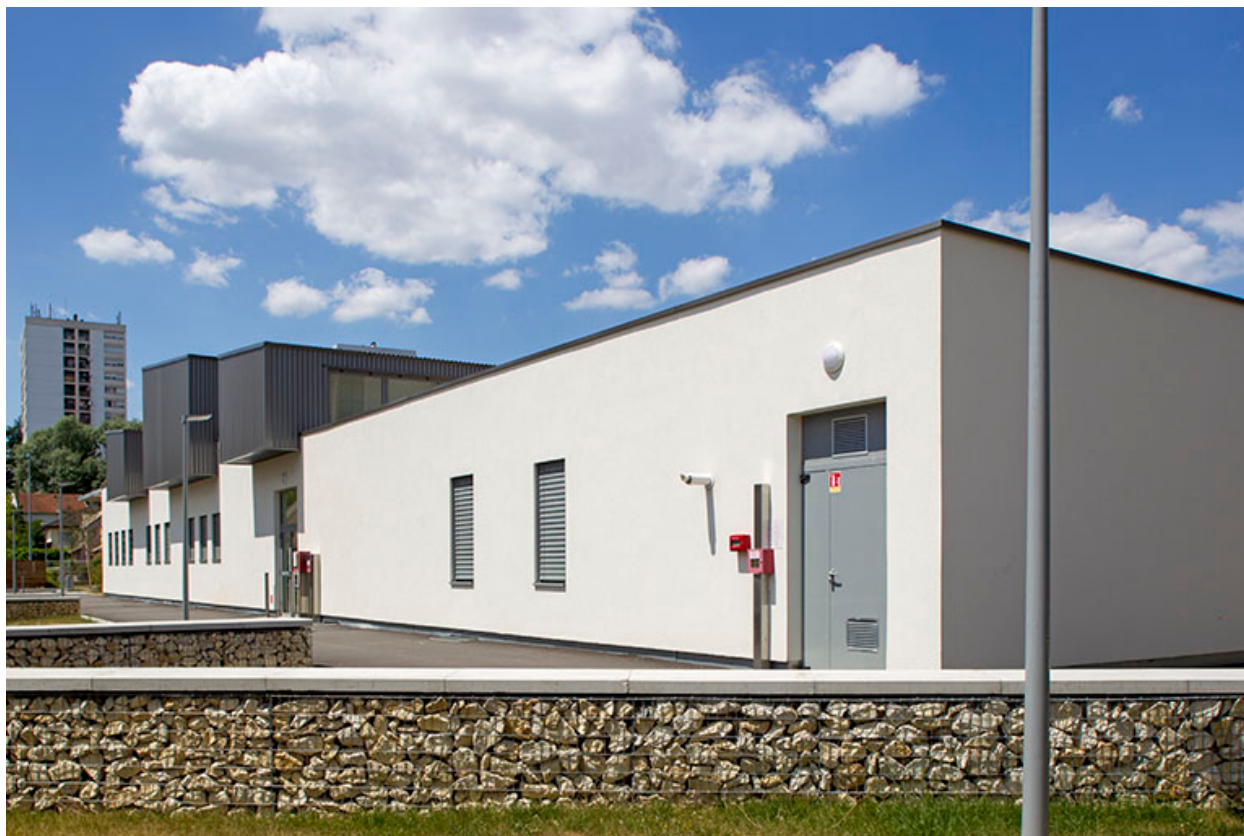
Fa ade sud du p le h telier, vue de trois-quart sud-est.
