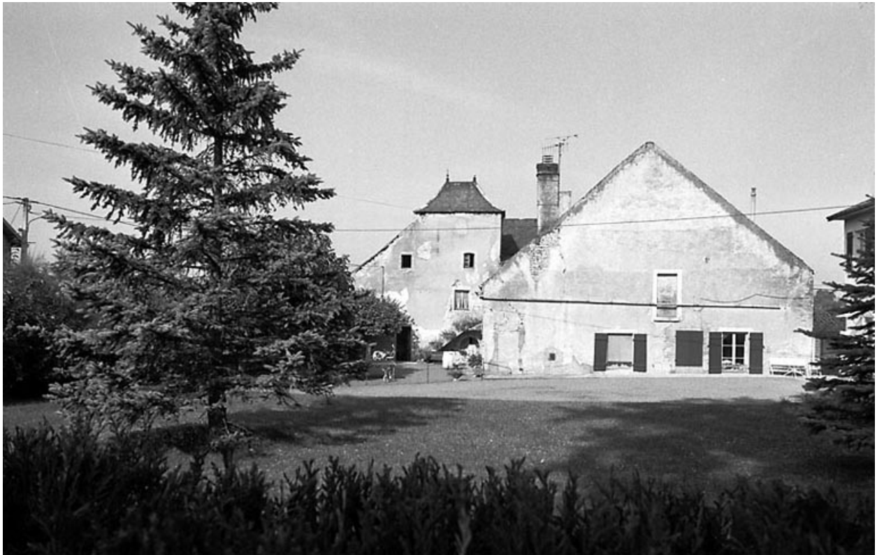
Façade latérale droite.
